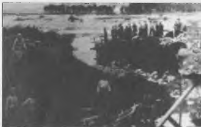
1920-Valentí Fargnoli. Reconstrucció de la resclosa d'en Joga -embocadura del canal de la Gròber- desfeta pels aiguats de tardor. Cada any, des de l'Edat Mitjana, hem reconstruït la resclosa del molí i la de la sèquia Monar amb rierencs, feixines, estaqües de roure i morter de calç. Ara vivim refiats de la resclosa de Susqueda, amb la tranquil·litat de saber que, si torna a guanyar el riu, ja no caldrà refer res.
