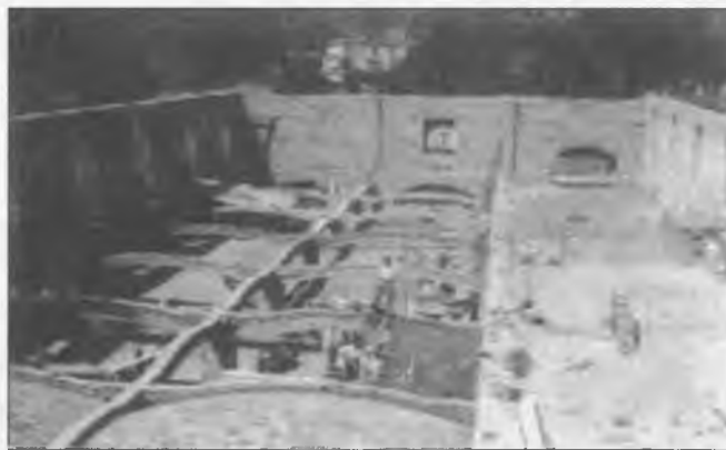
1942-Josep Frigolé Grau. Ampliació de la fàbrica tèxtil Gròber S.A. El 1893 l'empresa comprà el molí de Benages, propietat de la casa dels comtes de Berenguer, que apareix al fons. El dret sobre les aigües del Ter, que el molí posseïa des del segle XVI, es va aplicar a una central hidroelèctrica que també subministrava la fàbrica de Girona.
