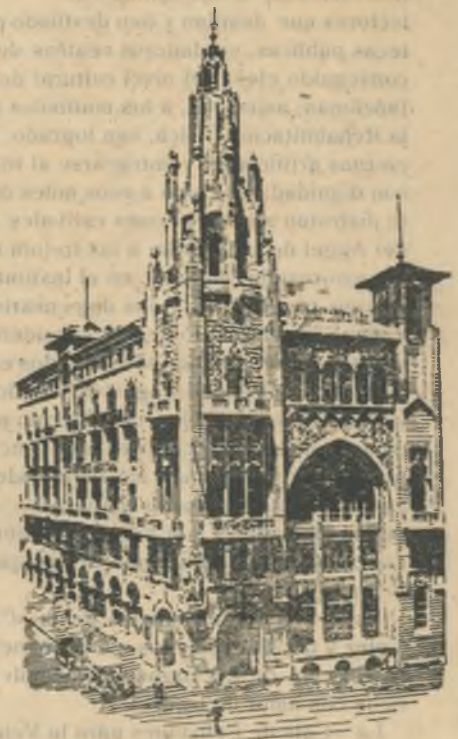
Edificio de la Oficina Central de la Caja de Pensiones para la Vejez y de Ahorros, sobre la cual se publica un reportaje en última página.
