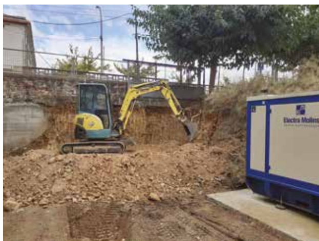
Moviment de terres i canalitzacions prèvies
