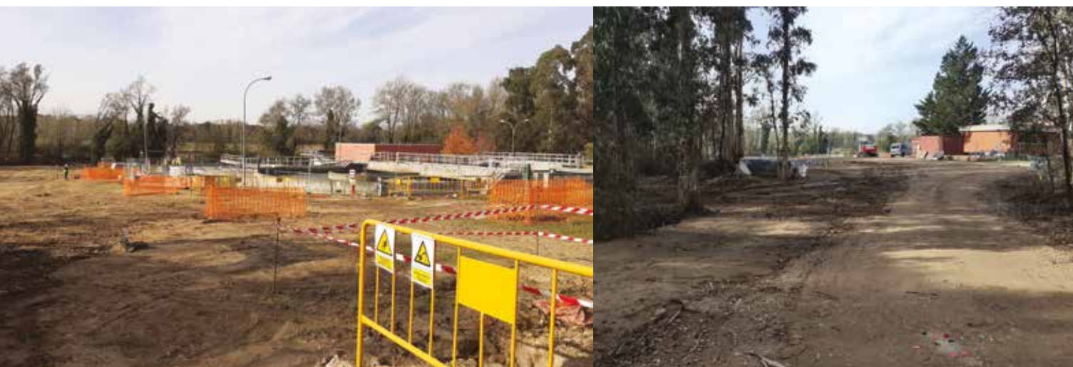
Dues imatges dels inicis de l'obra de l'ampliació de la depuradora.
