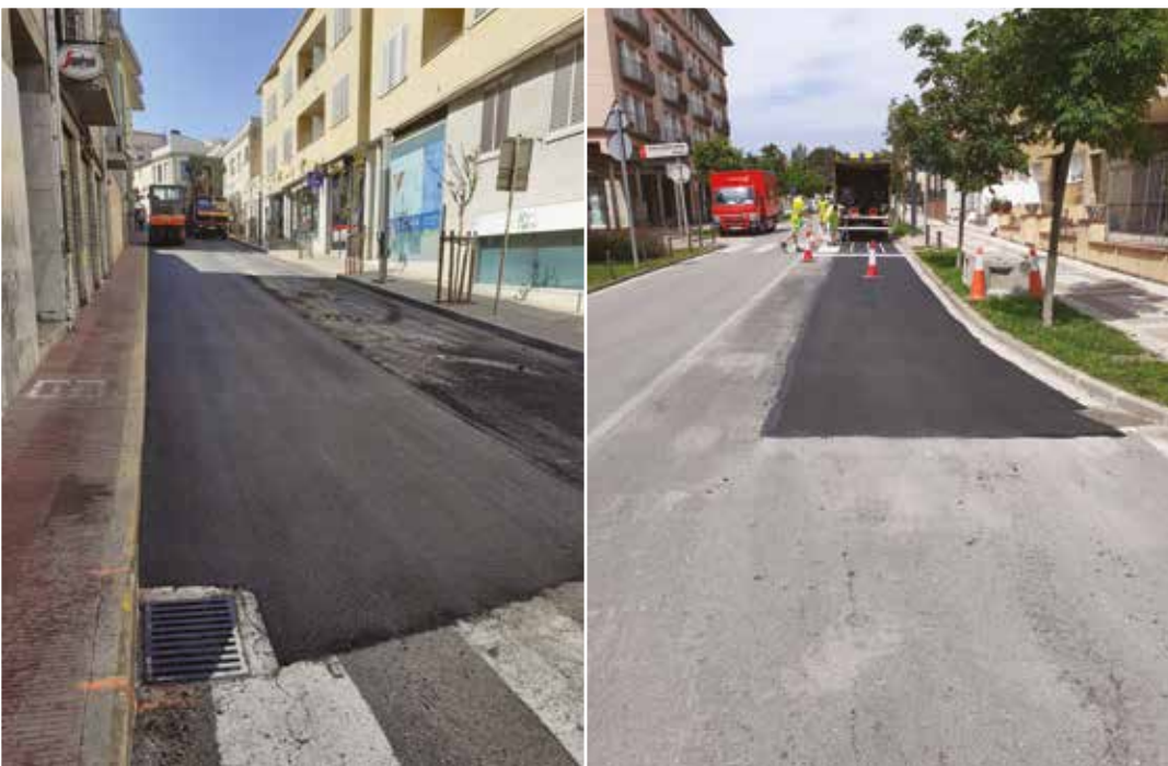
A l'esquerra, moment del fresat del ferm a la baixada de la Coma. A la dreta, asfaltatge d'un tram de la Rambla i pintat del pas de vianants.
