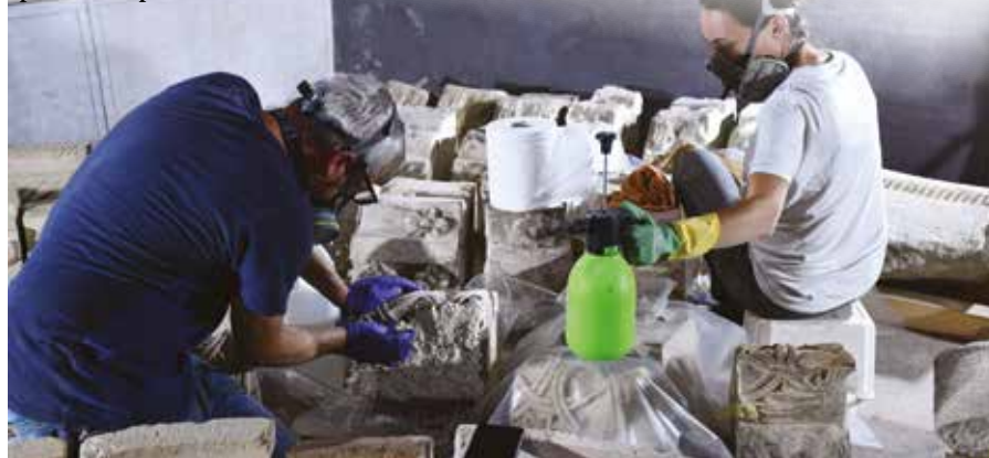
Treballs de restauració de les pedres de la portalada romànica
