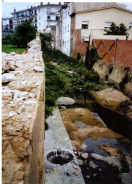
Estat de la riera de Tueda abans de les obres.
