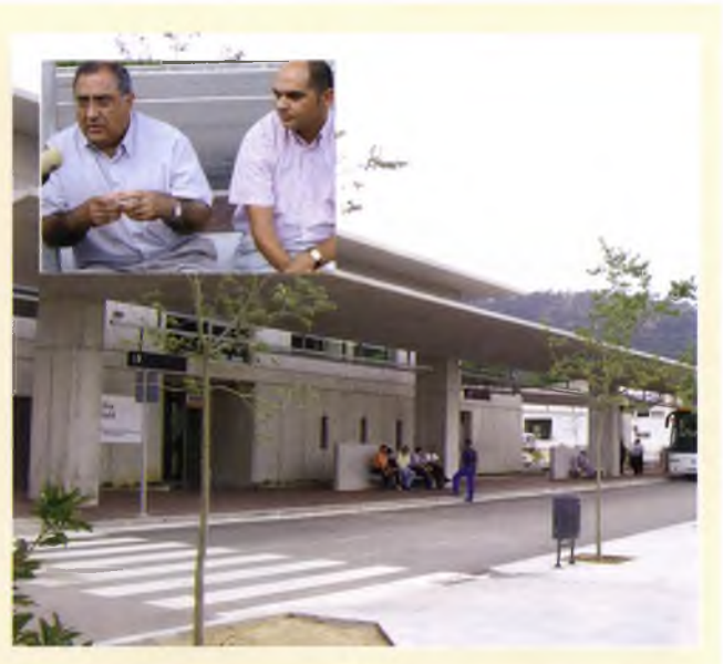
A dalt, moment de la visita d'obres del conseller Joaquim Nadal. A la imatge gran, la nova estació d'autobusos
