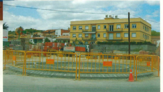
Construcció d'un giratori de la Ronda de Ponent
