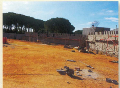
L'Ajuntament va començar a construir el nou dipòsit municipal de vehicles al gener, al costat de la Petanca i la Deixalleria municipal. Aquí es començaven a veure les parets.
