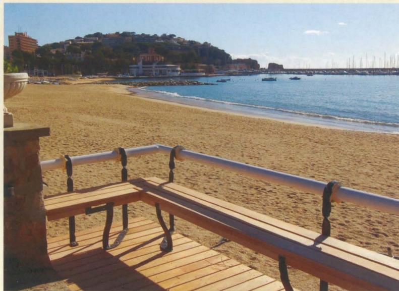
Al mes de març es va fer una actuació de reforma i adequació de les baranes de mar, amb un aspecte més modern, amb tractaments de fusta.
