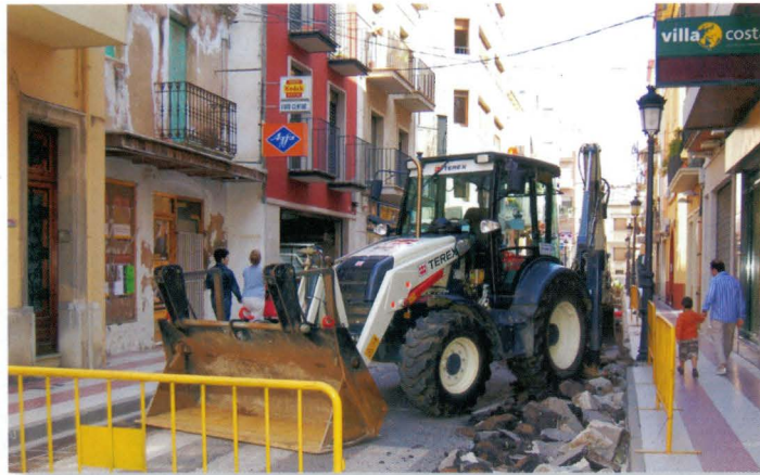
Inici de les obres del carrer Major, a mitjans del mes de setembre
