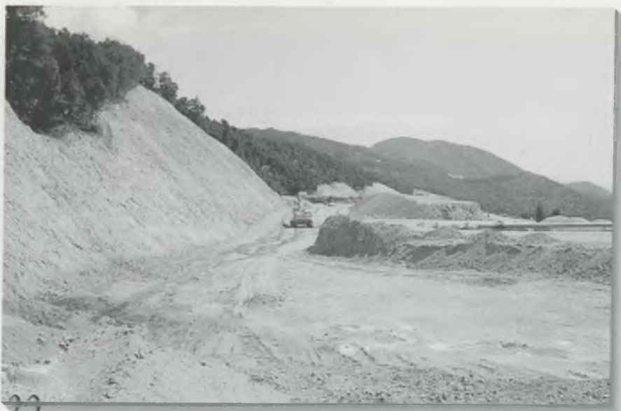
Estat actual de les obres de l'Eix a la zona de Coll de Ravell. Foto J.Camps.
