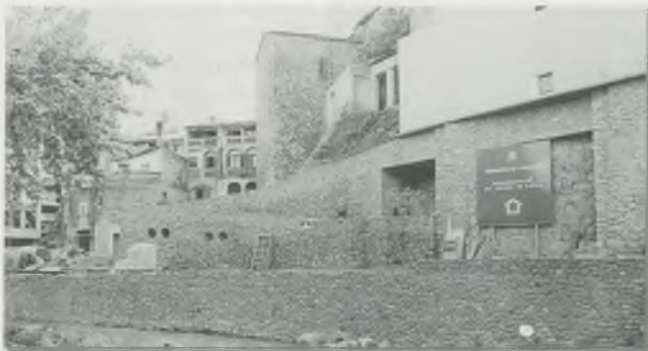
Obres de rehabilitació de les façanes del sector de la riera
