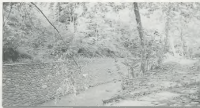
Mur de defensa de la riera d'Arbúcies
