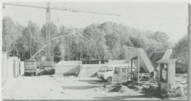
Construcció de la nova depuradora
