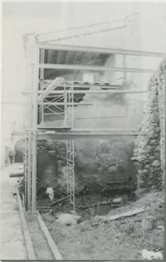
Obres d'adequació de can Son Foto: Arxiu Perxada
