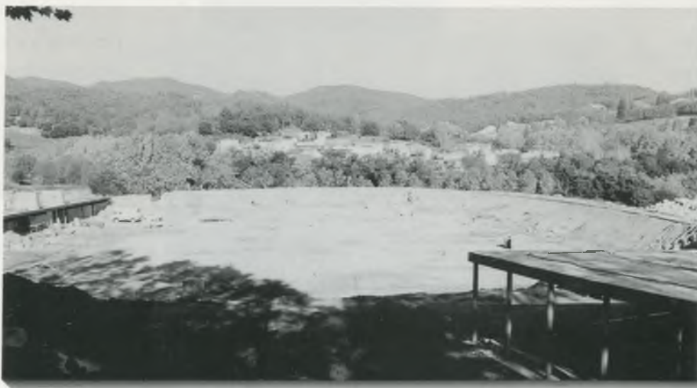
Obres de construcció del nou camp de futbol. Foto: arxiu Perxada
