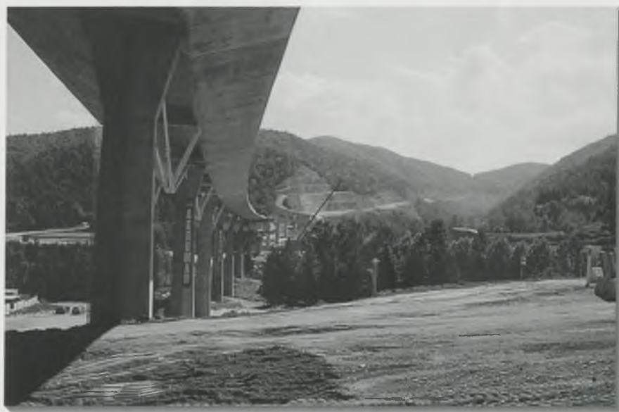
Viaducte de La Cantina, a Espinelves. Foto J.Camps.
