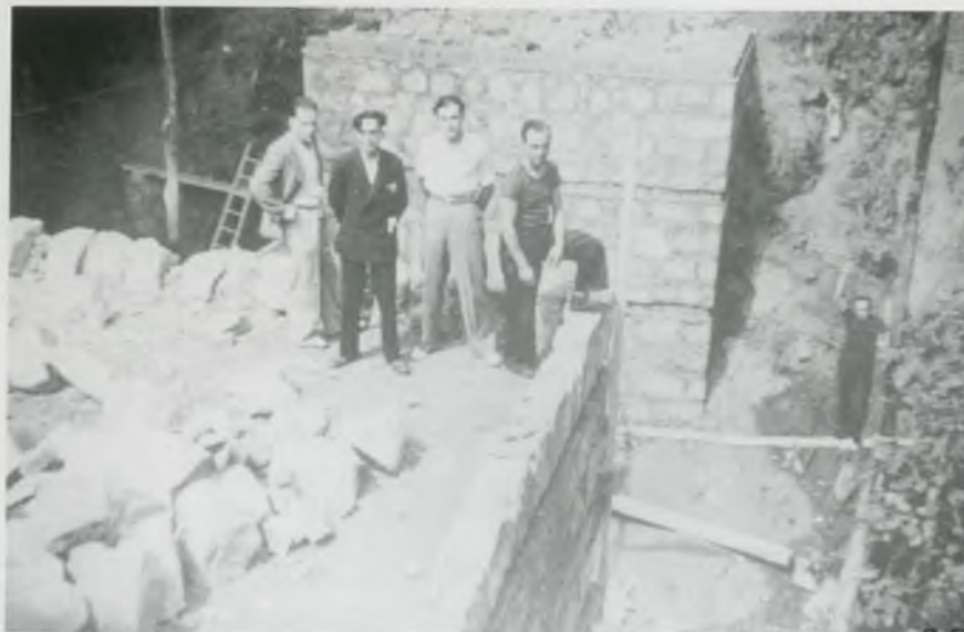
Construcció del conegut com a "Pont dels Rojos".
