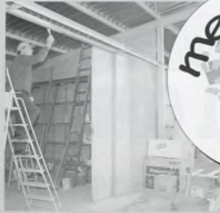
Detall de la deixalleria en construcció.
