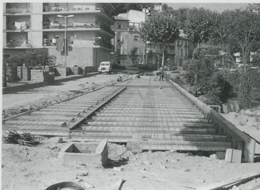
Treballs de remodelació del pont.
