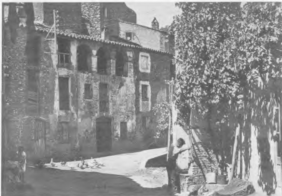
Placeta de can Jombo i una de les bombes instal·lades el 1908.
