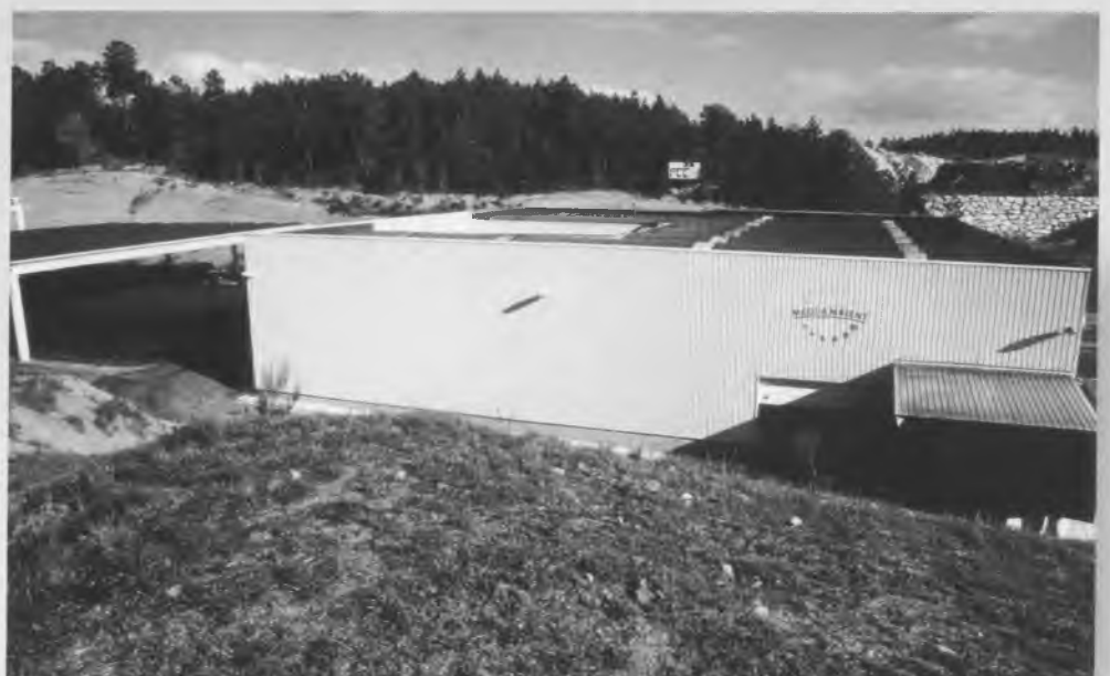
Panoràmica de la planta de compostatge a Santa Coloma de Farners.
