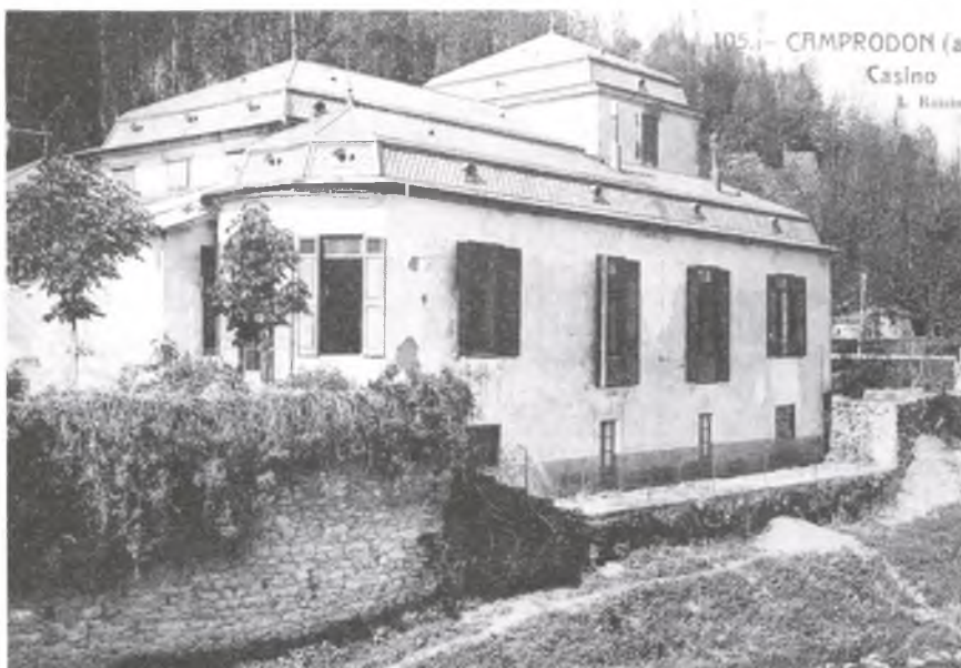
L'edifici del «Casino» abans de l'incendi.
