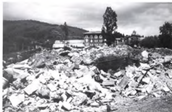
Des del mateix indret a l'altra banda de la carretera.
