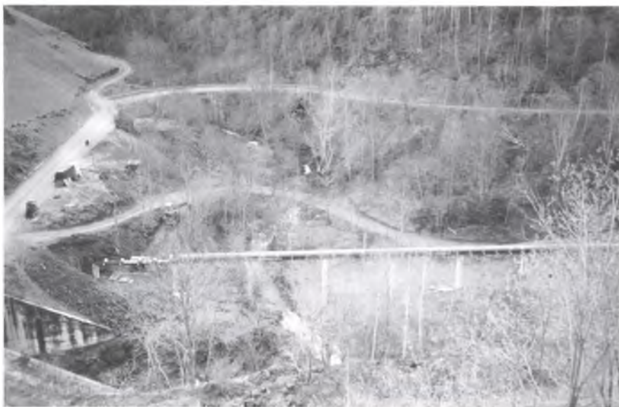
Les obres de la nova central de Molló.
