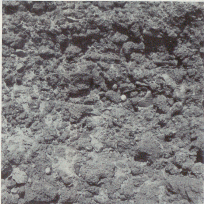
Detall de la muralla romana de formigó en massa d'Emporiae.
