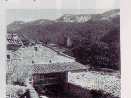
Un pati (l'era), fa d'element distribuïdor, al front s'emplaça l'habitatge, mentre que els laterals són construccions per al bestiar. Cal Porta. (Adraen).
