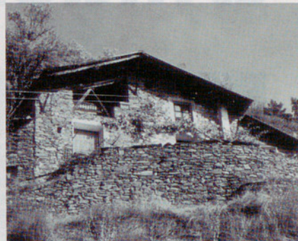
Prolongació de la teulada per protegir l'entrada de la vivenda de la neu i la pluja. Cal Feliu. (Pallerols del Cantó).
