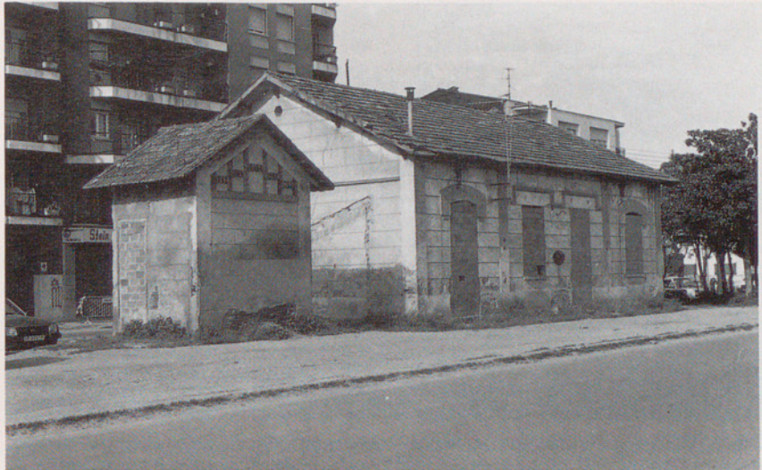
ESTACIÓ DEL VEÏNAT (conjunt d'estació i lavabos). "L'estació del tren a Salt es va instal·lar al veïnat o barri de Sant Antoni, que oferia més usuaris que la Ciutat Vella".
