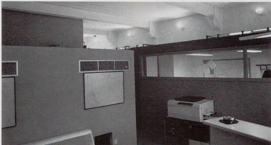
LOCALS POLICIA MUNICIPAL (Interior des de l'entrada). "L'esplèndid espai interior imaginat per Ricard Giralt el 1937 per a la seva sala-cafè no s'ha pogut admirar fins avui, amb la rehabilitació de 1990".
