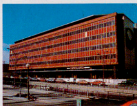
Santa Eulalia, 236-242 HOSPITALET DE LLOBREGAT (Barcelona)
