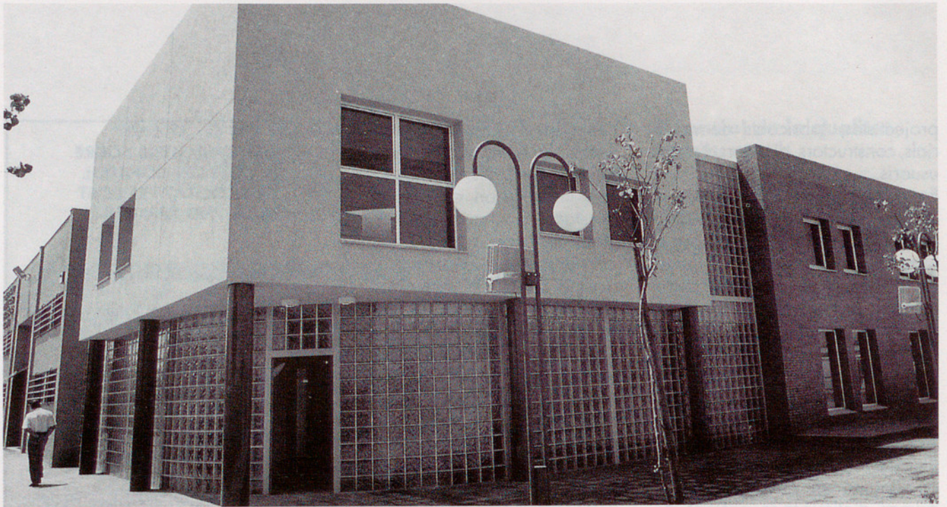
Façana d'accés al laboratori de Celrà.
