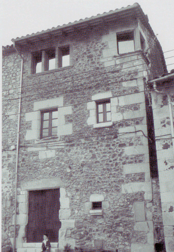
Després de rehabilitar
