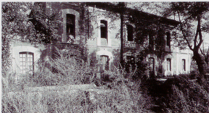
Vista general de la façana que donava a les vies abans de la intervenció de l'Escola Taller.
