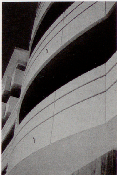
Façana de l'Edifici de Premsa dels JJ OO de Barcelona (1992), realitzada amb formigó reforçat amb fibra de vidre AR.
