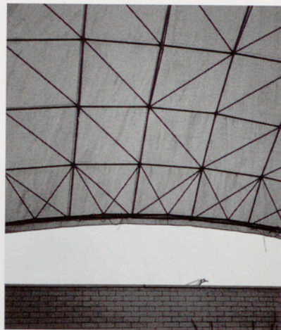
L. Sánchez C. Estructura ultralleugera de barres amb membrana de lona. Escola Politècnica. Girona, 1990.
