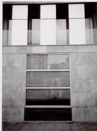
E. Borrell, J.M. Gil Contrast de panells lleugers d'alumini sobre la pesadesa d'un aplacat de pedra de Girona. Edifici dels Jutjats. Girona.
