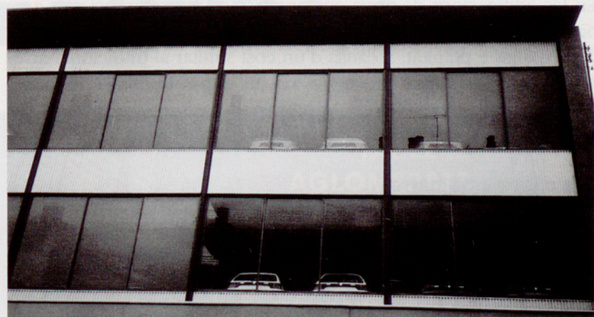
J.M. de Ribot Inici de mur cortina amb xapa Pegaso, perfil·leria i vidre. C. Barcelona, 39. Girona, 1957.
