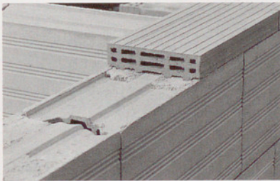
Figura 1. L'eliminació de juntes permet guanyar temps en la posada en obra.
