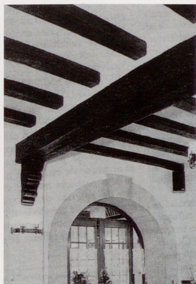
Restauració d'una edificació mitjançant perfils de poliuretà.
