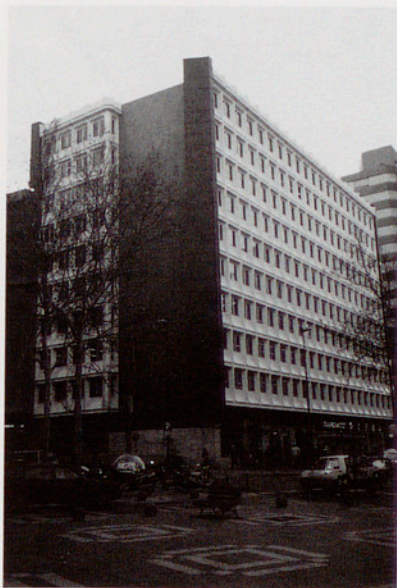
Façana de l'hotel Palafox (Saragossa), realitzada amb fibra de vidre/resina de polièster.
