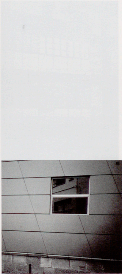
Q. Pla, J. Padrosa. Façana ventilada amb pell d'alumini PVFD sobre perfils Halfeneisen. Edifici dels Mossos d'Esquadra. Girona, 1993.
