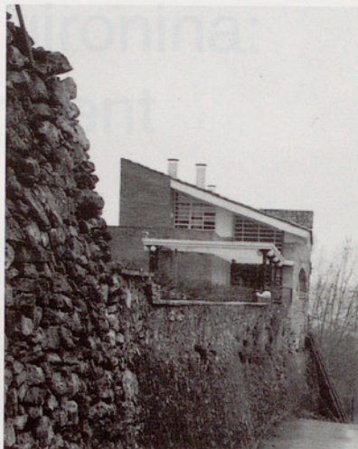
F. Figa, P. Pla. Bona harmonització de les tecnologies de la pedra, obra vista, arrebossat i vidre. Casa Mataró. Girona, 1989.
