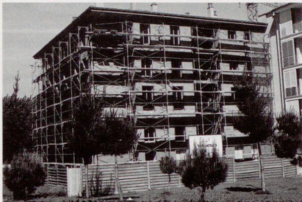
Mesures de treball i seguretat adoptades en una obra tipus.
