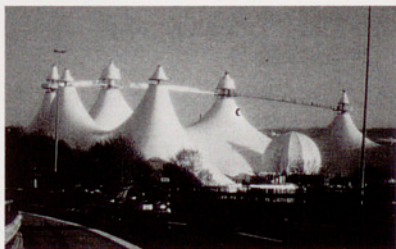
Exposició Heureka a Zuric, Suïssa (1991), la construcció d'arquitectura tèxtil més gran del món, amb 30.000 m 2 de planta en dos nivells i una alçada de pals de 42 m.
