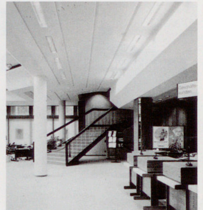
Sostre d'habitable (Alemanya) prefabricat de cartró-guix (obra seca).
