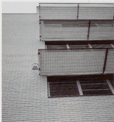
Ll. Cantallops. Claredat tecnològica de tancament pesat i "brise-soleil" lleuger. Edifici de la Politècnica I. Girona, 1985.
