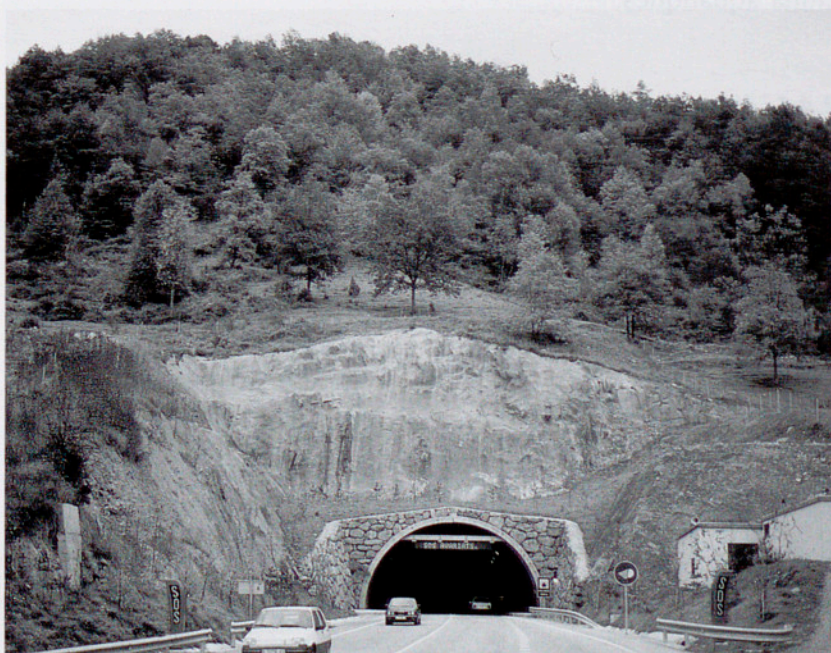
Els túnels són la millor garantia per permeabilitzar una infraestructura (Capsacosta).
