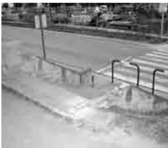
Les construccions urbanes es deterioren.
