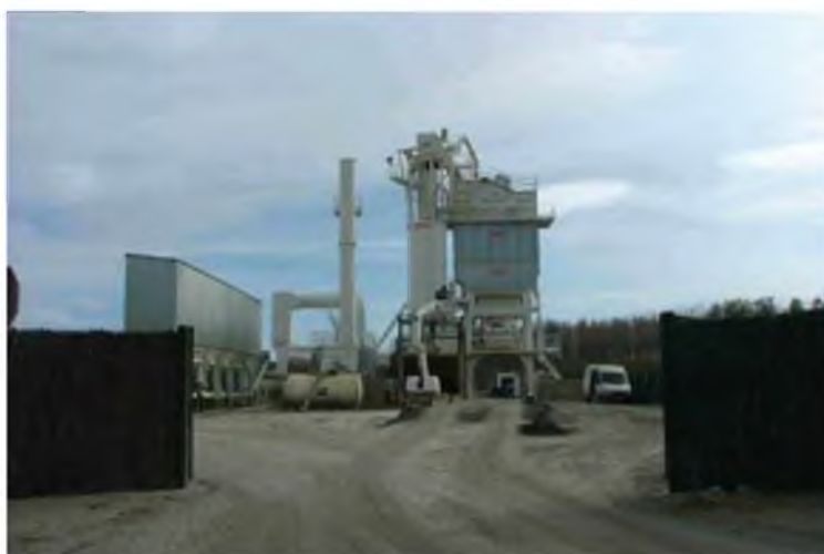
Imatge de la planta asfàltica.
