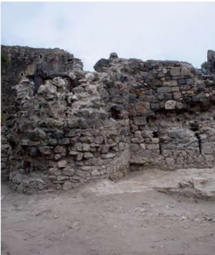
La torre sud-oest i la muralla sud, amb les tres espitlleres, vistes des de l'exterior de la fortificació.
