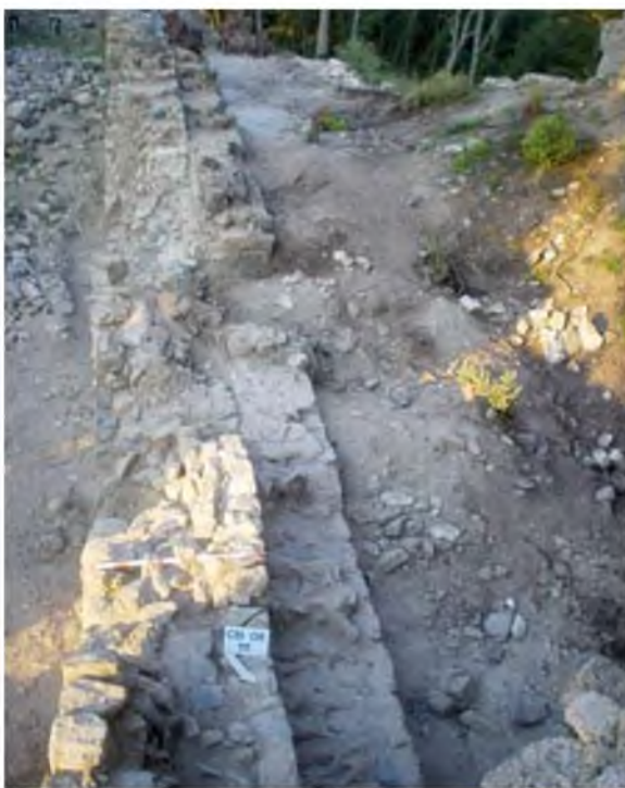
La muralla oest del recinte principal, a l'esquerra, amb el mur de llevant del cos oest, adossat a la seva dreta.
