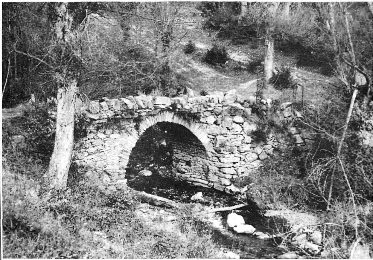
Pont per anar a Les Coves d'Olapte (Foto A. Brasel)
