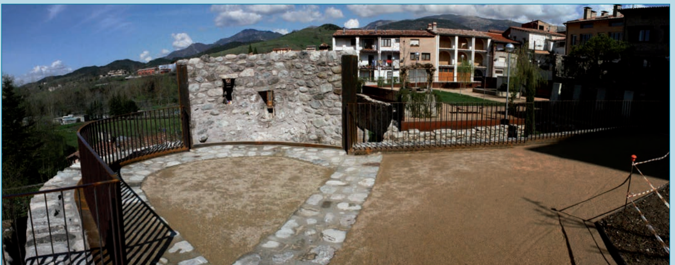
Estat actual de la torre que controlava el portal
