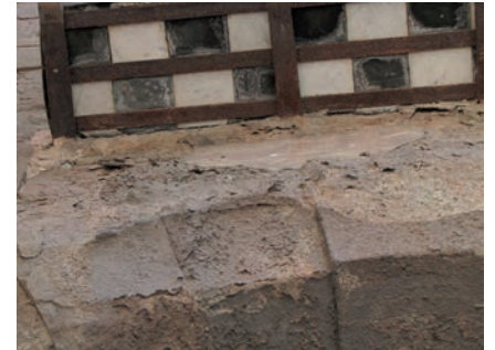
Part inferior d'un balcó abans de la neteja de la pedra
