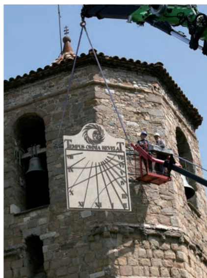
Instal·lació del rellotge al campanar de Sant Pol
