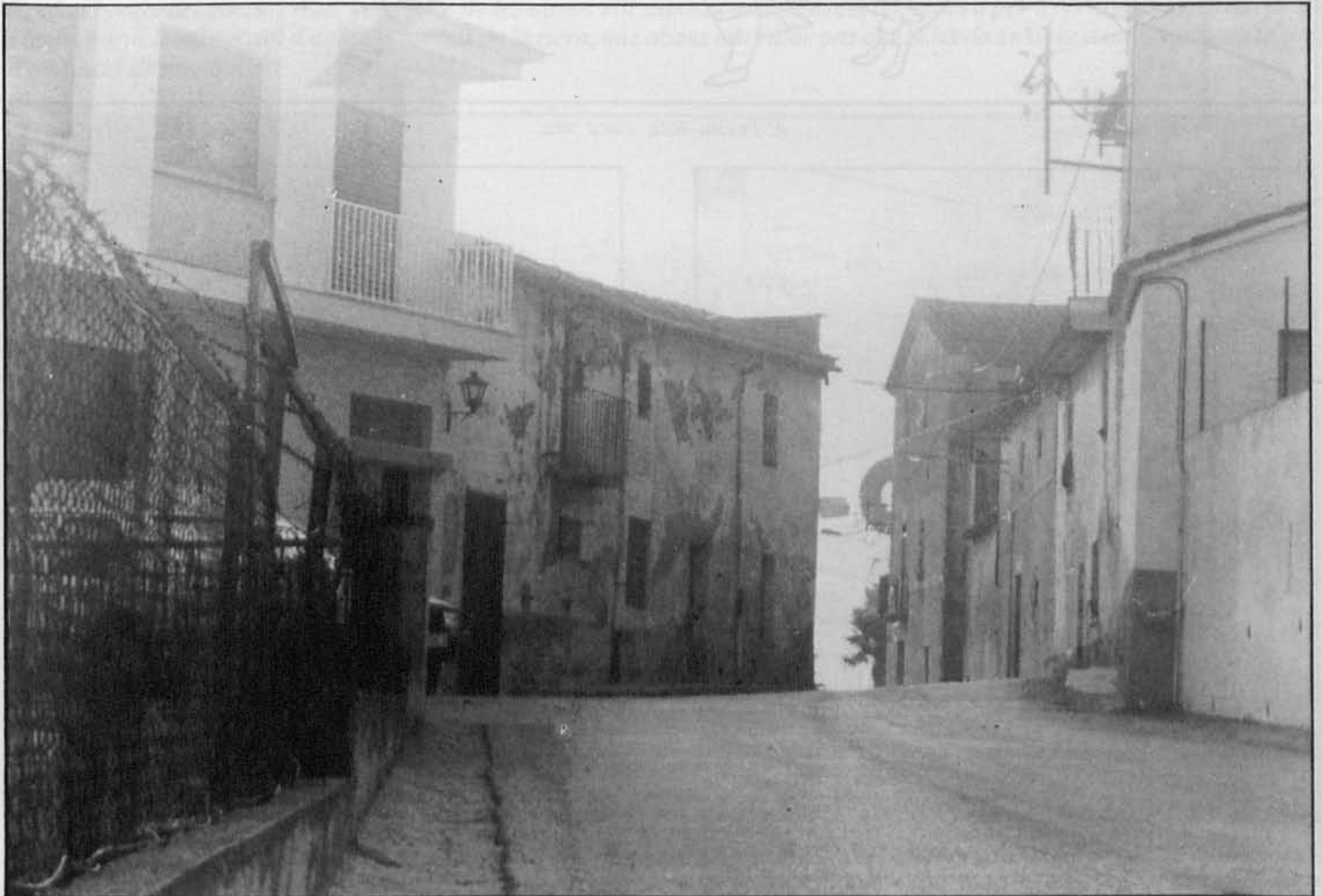
Carrer SANT DALMAI.- Forma part de l'entrada a Salitja per la carretera que anava de Brunyola a Salitja i que a la sortida del poble dóna lloc a la carretera de Caldes. Comença al pas estret de cal Campaner i és on hi ha el nucli urbà més antic juntament amb la plaça de l'Església.
