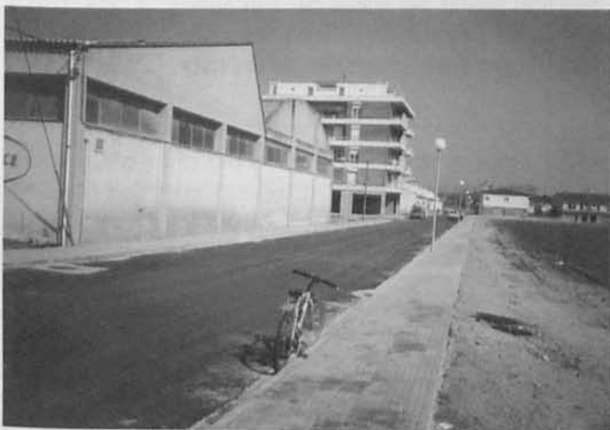
Obres d'acondicionament al carrer Pere Antoni
