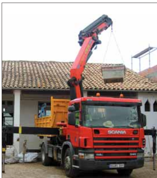
Comença l'enderrocament de la Ludoteca Municipal el Sol
