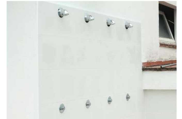
L'Ajuntament aplica millores a les instal·lacions de la piscina de Salitja
