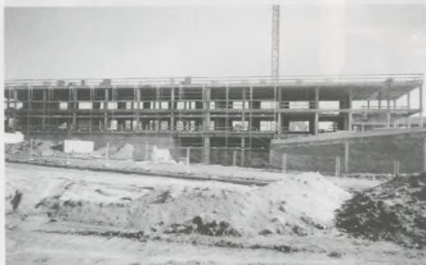
Així estaven les obres al desembre del 2002.
