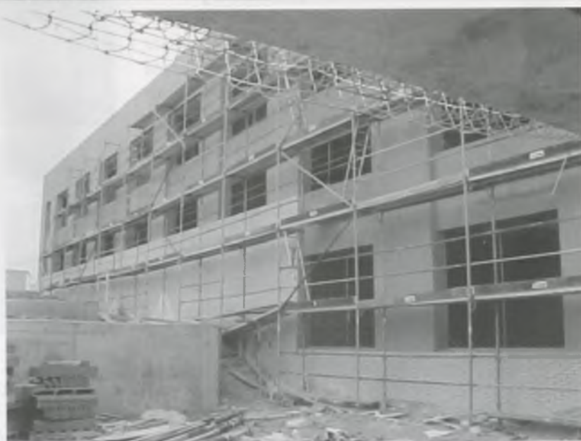
Així estan les obres el 19 de maig del 2003
