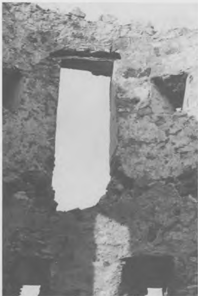
Aspecte de l'interior de la Torre. El seu diàmetre interior és de 5 m. aproximadament.
