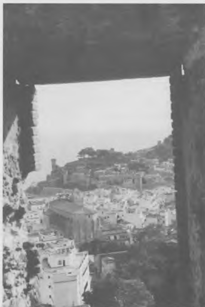
Tossa d'abans i d'avui vista des de la Torre dels Moros. A la fotografia es pot observar el dintell prefabricat que ha calgut col.locar a l'entrada de la Torre.
