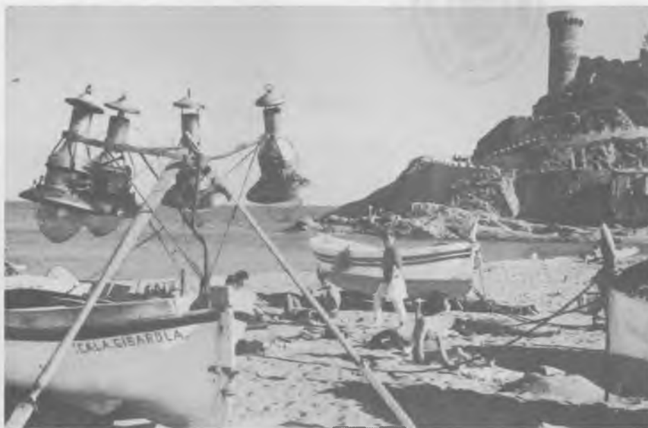
Llums muntats a dalt d'un bussí amb els tubs i el dipòsit. (Any 1960) Foto: Arxiu de l'autor
