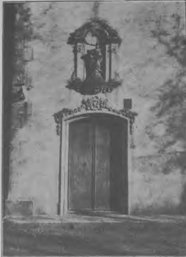
Vista parcial de la façana
