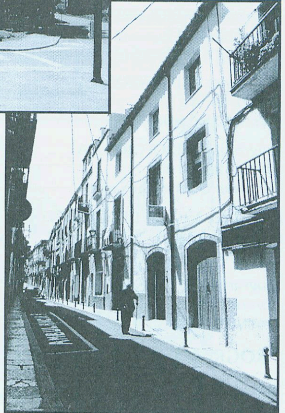
Arranjament carrer Major i rehabilitació façana del CAP
