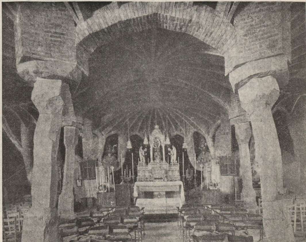
...en ...ate. Interior de la cripta de la Colonia Güell con arcos y pi- lares en posición equilibrada.
