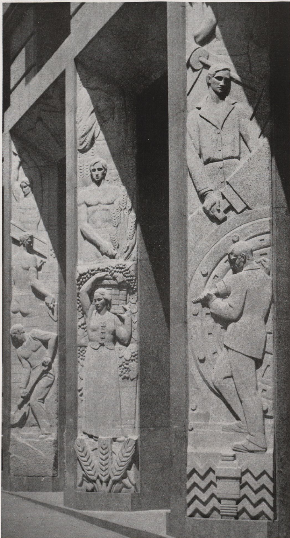
F. Marés. Relieves que decoran la fachada del nuevo edificio central del Banco Hispano Americano, en Barcelona, 1957.
