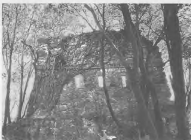
Torre de Telègrafs.
