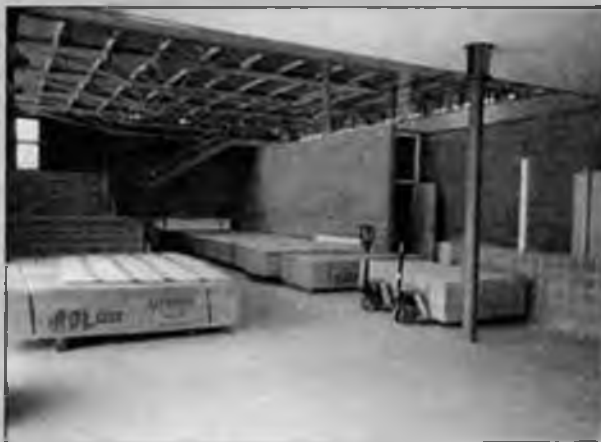
Material per al terra del pavelló.
