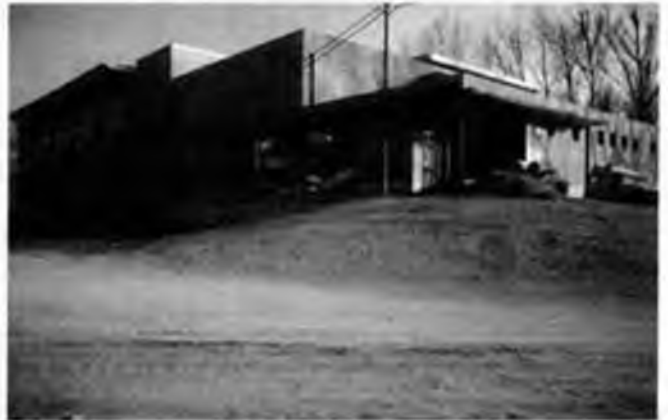
El pavelló, mig any enrere, en obres.
