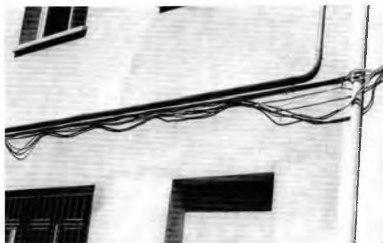
Cables que distorsionen l'estètica de les façanes.
