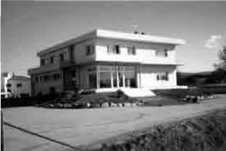
El nou Centre Cívic de Vidreres, quan s'acabaven d'iniciar els treballs d'enjardinament i ordenació del seu entorn que s'hi duen a terme actualment.
