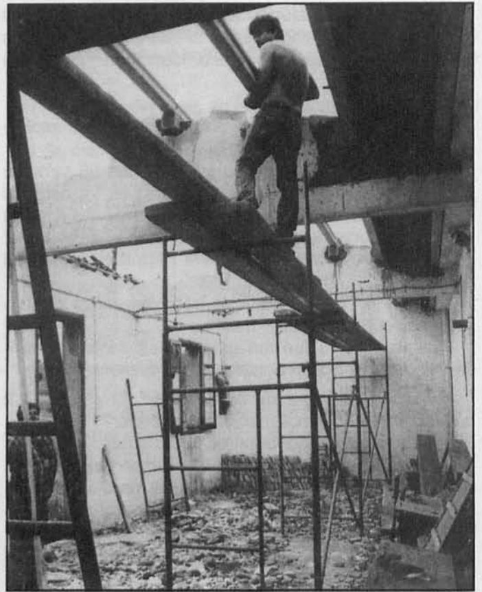
Un moment de les obres.
