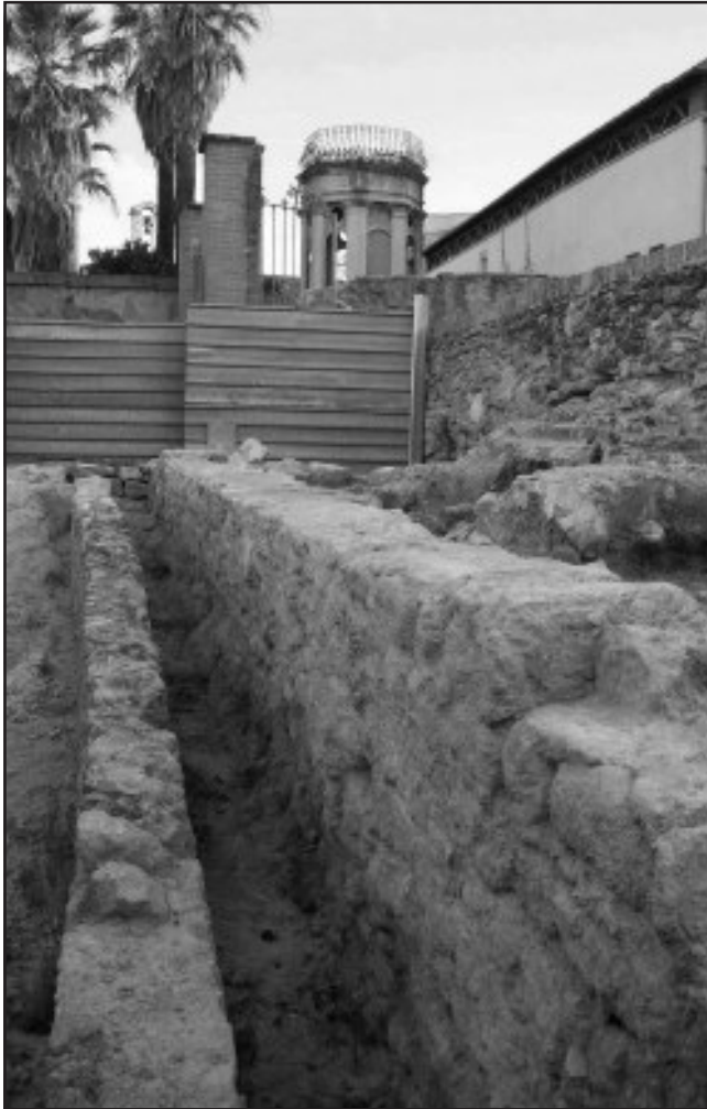
La paret original a la dreta amb un mur de reforç a l'esquerra
