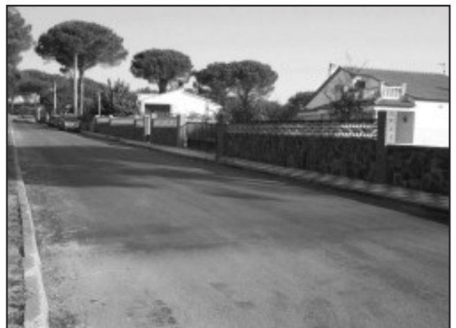
Obres d'asfaltat del carrer Empordà
