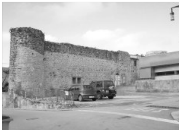
Part afectada per la primera fase del projecte
