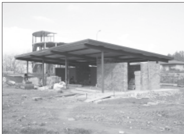
Les obres a finals de novembre
