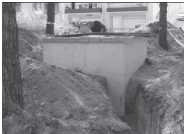
La construcció soterrada que conté la bomba
