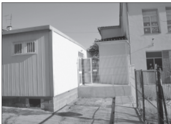
El mòdul prefabricat al costat de l'edifici
